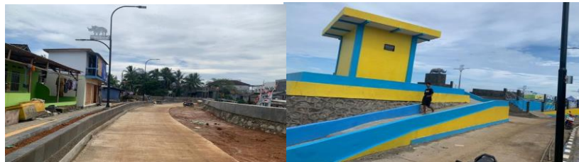
Gambar 2 Hasil Pembangunan Program KOTAKU di Desa Teluk Kecamatan Labuan Kabupaten Pandeglang
