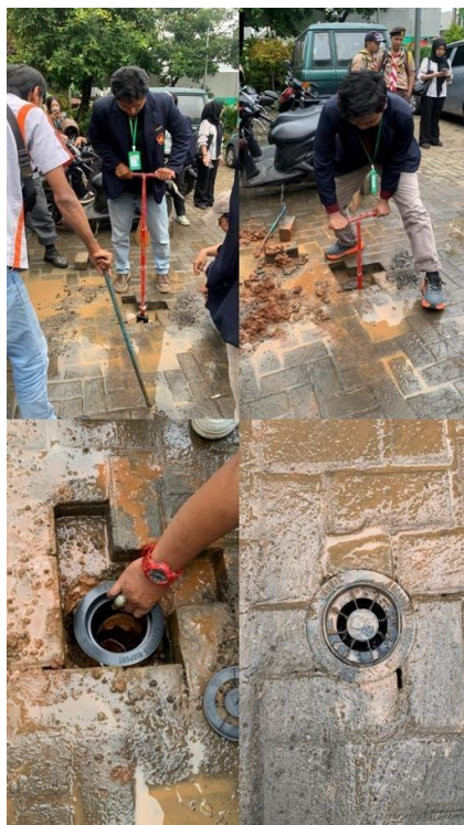
Gambar 2 : Pembuatan Lubang Biopori
